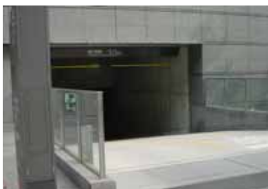
新丸ビルの地下駐車場出入口
