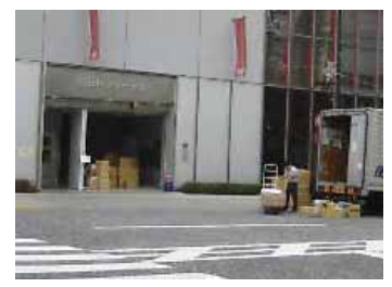
大規模商業施設の荷捌き施設 小さくて2台車も入れない。実際には、荷物置き場として利用されている。
