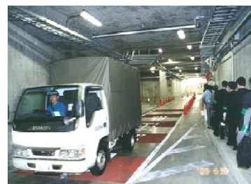
〈貨物車が走行できる走行路(トンネル)〉
