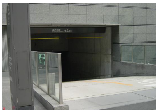
【高さ制限 3.0m】(丸ビル)
