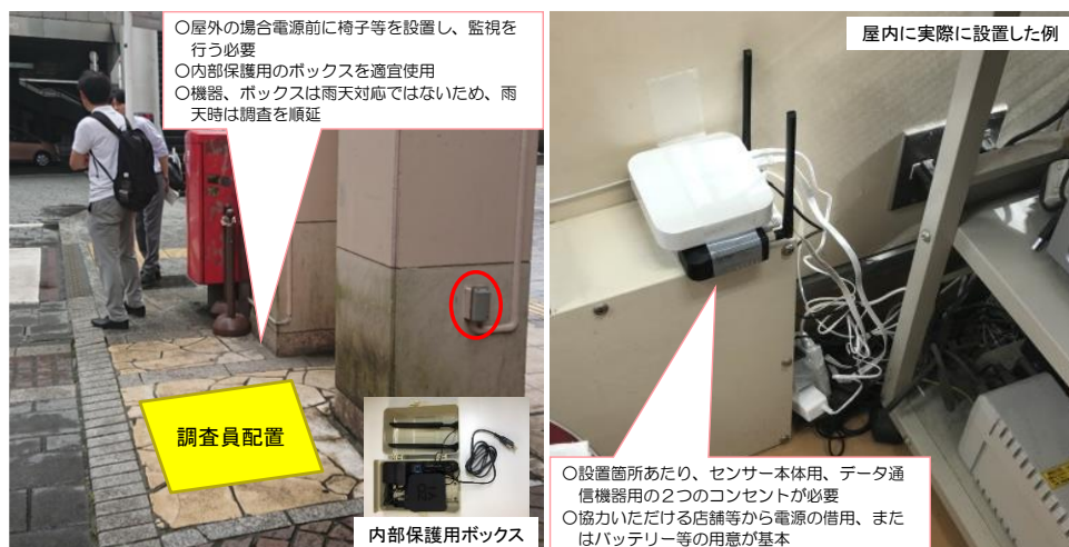
図 2-6 Wi-Fi センサーの設置状況
